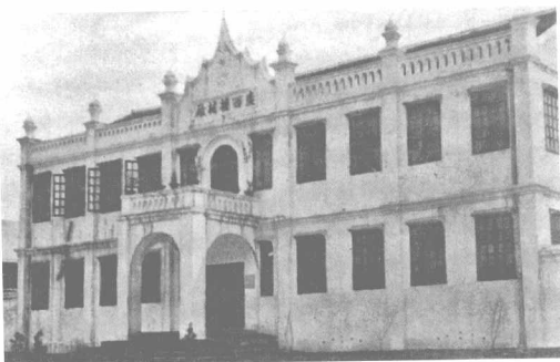
1931年10月至1932年11月间，工厂称“广西机械厂”，图为当时的广西机械厂大楼。
