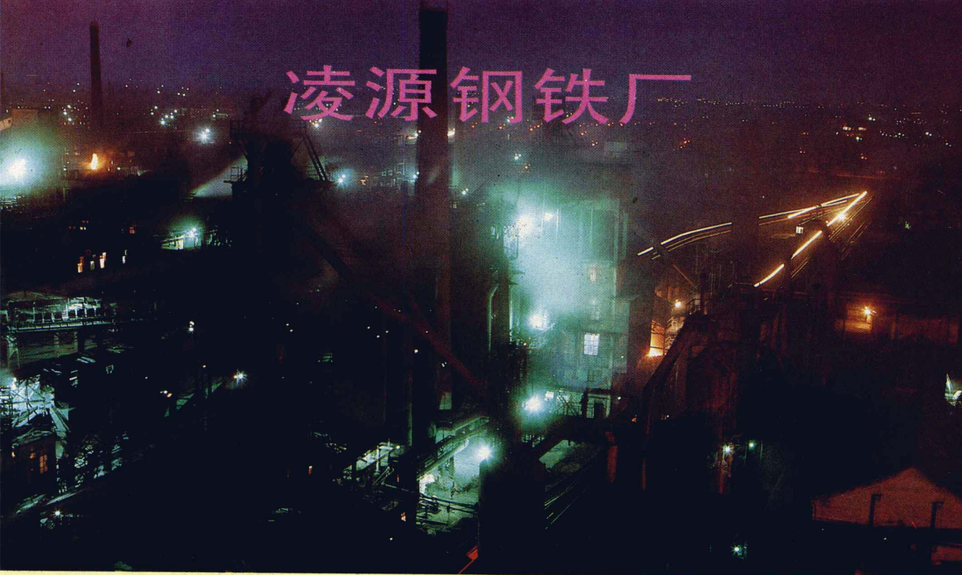
凌钢高炉夜景
