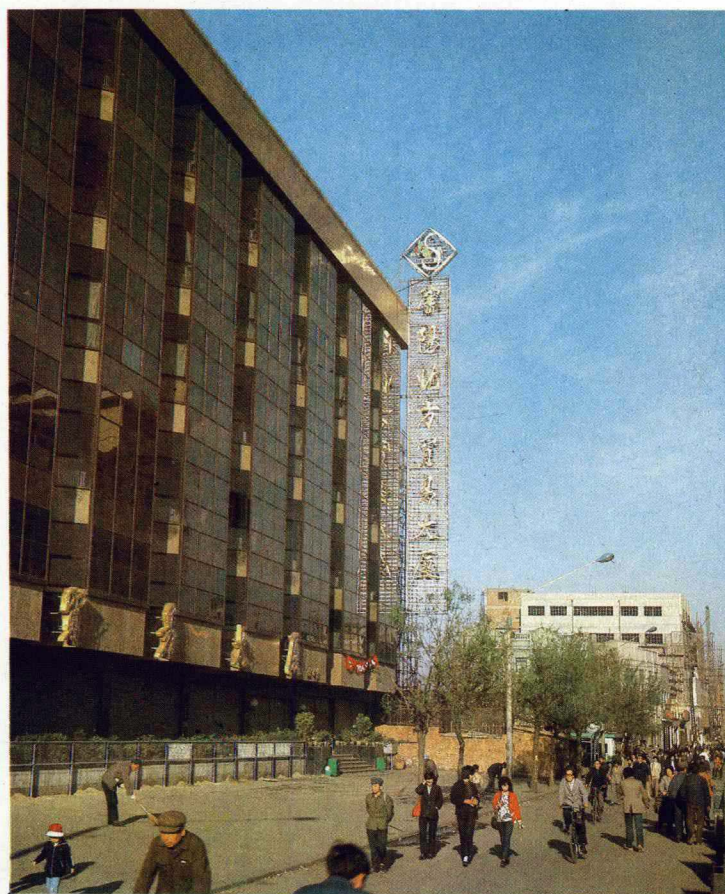
沈 阳 北 方 贸 易 大 厦
