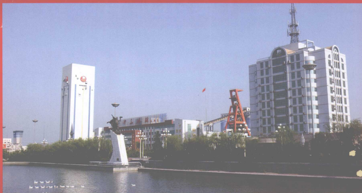
现代化的兖矿集团济三煤矿
