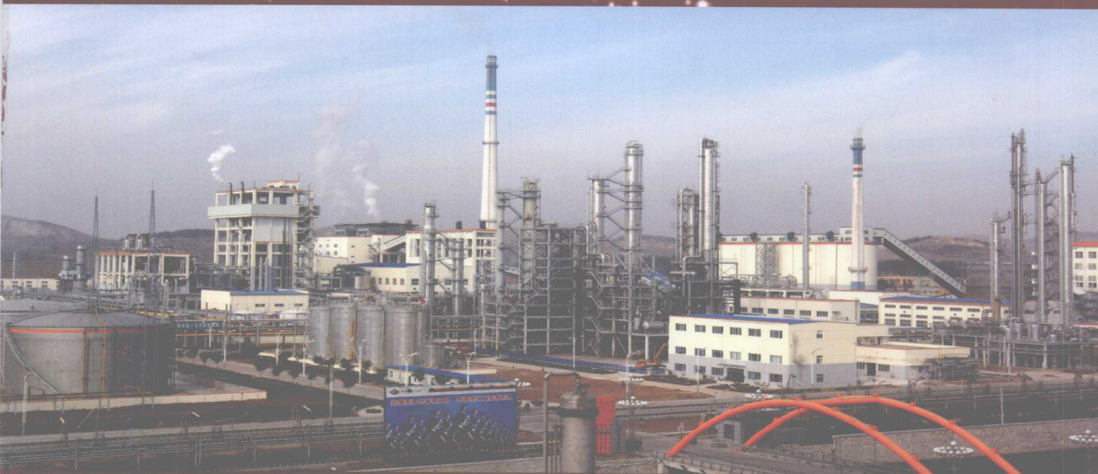
建设中的兖矿煤化工
