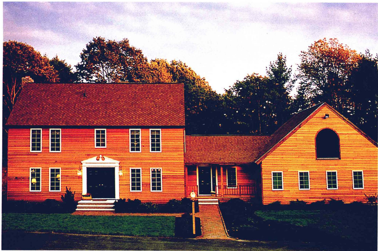
入口处古典构件的强烈介入，显得与建筑格格不入，但强调了入口。
