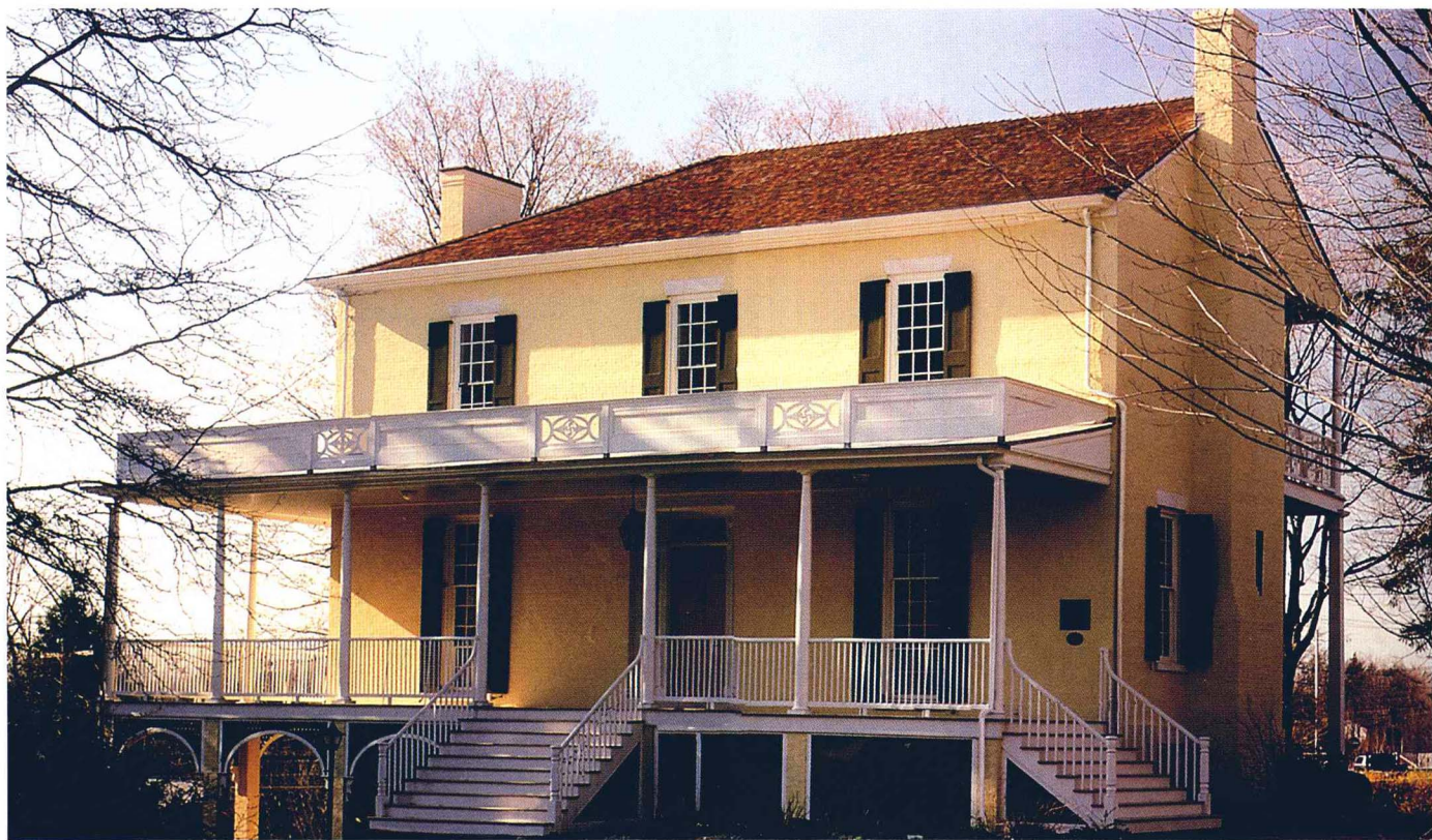
室外楼梯的布局别具一格，廊的大量介入，给主人提供了灵活的生活空间。
