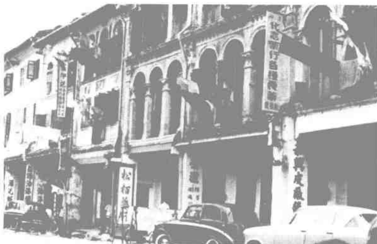
松柏街的三层楼店屋，在这些店屋里，居然住了338人。（摄于1955年）
