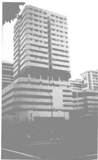
旧店屋拆除后，高楼从废墟上建起，这是今天福海大厦。
