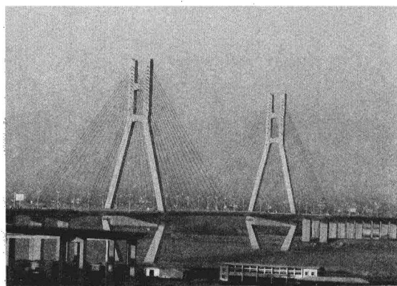
(d) 润扬北汊斜拉桥(主跨 406 m)
