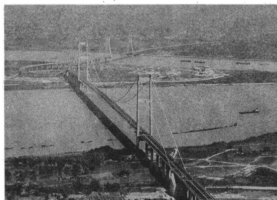
(c) 润扬南汊悬索桥(主跨 1 490 m)
