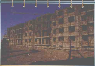
施工中的住宅小区
