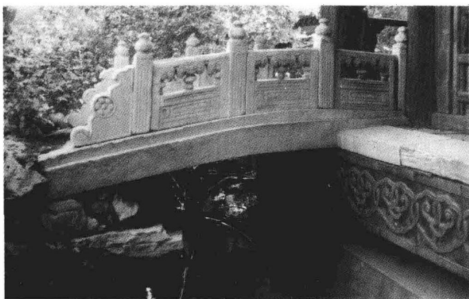
图2 北京故宫御花园跨楼石桥
