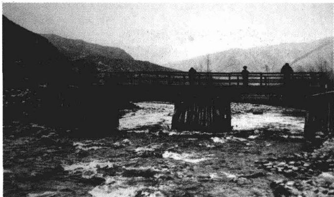
图7 西藏拉萨木墩木梁桥(现已拆除)
