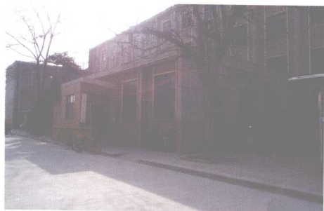
老行政办公楼后电话总机房 (曾为图书馆八大处之一)
