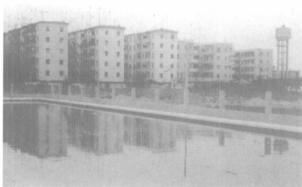
10月，位于市桥北郊的市桥新城区首期工程竣工
