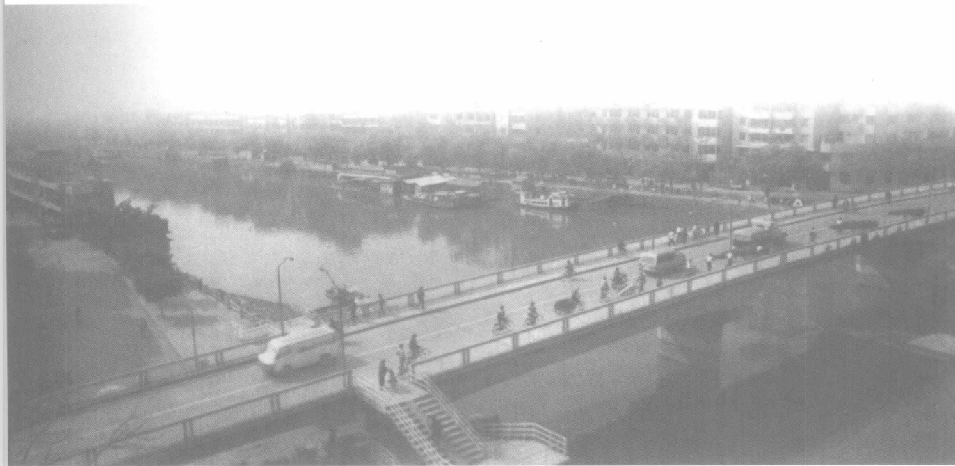
10月1日，首座横跨市桥河南北的桥梁——市桥大桥建成通车
