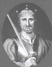
▲ 法国诺曼底公爵威廉一世为了确保伦敦的安全，在泰晤士河口通往伦敦的交通要道处，修建了伦敦塔。
