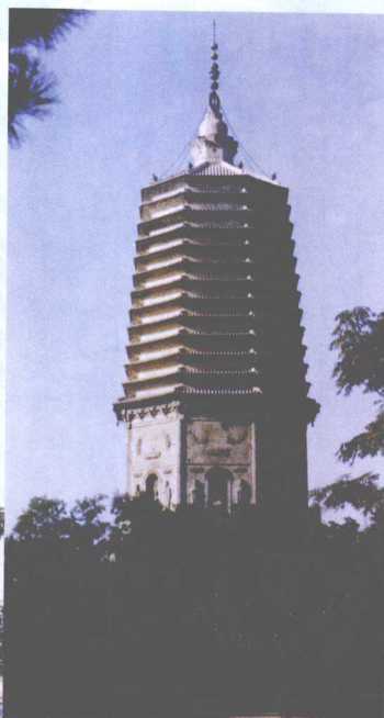
古建修缮工程
