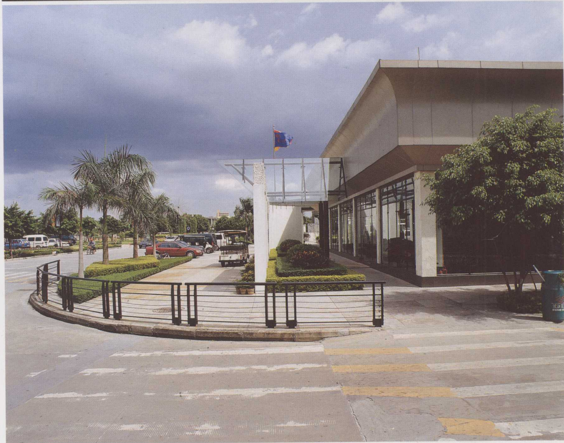
一过丽江大桥便可看见丽江花园的售楼部，绕过售楼部便是丽江花园的公交客运站。
