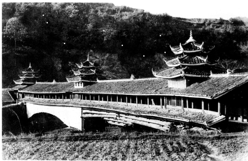
通道县迴龙桥
