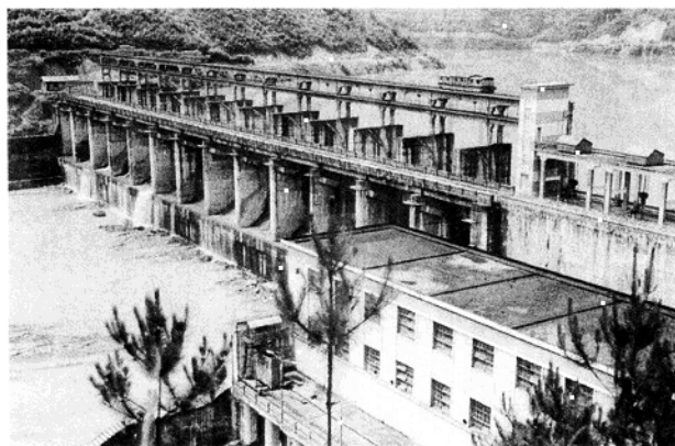
春阳滩电站大坝。
