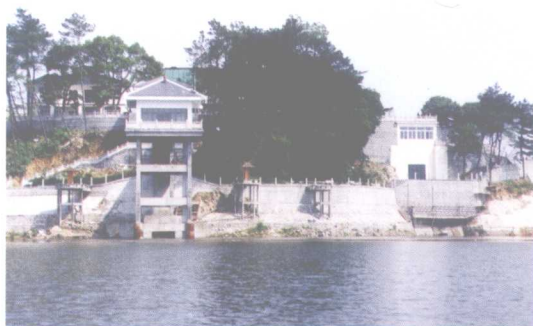
输水隧洞管理房
