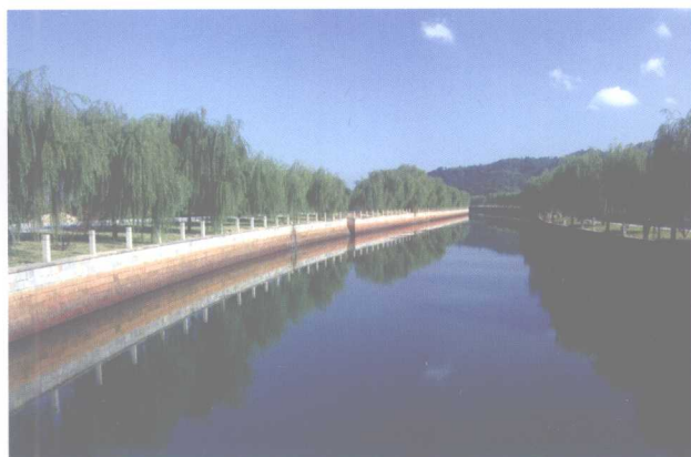
四明湖水库总渠
