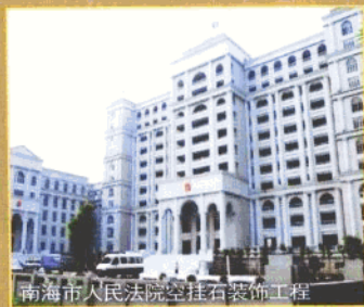
南海市人民法院空挂石装饰工程
