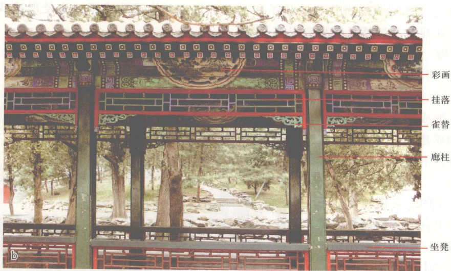
图1-4 长廊的组成部分 a)南京瞻园长廊 b)北京颐和园长廊
