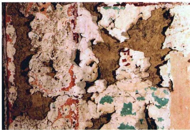
2. 莫高窟第 85 窟壁画颜料层连同白粉层大片起甲
