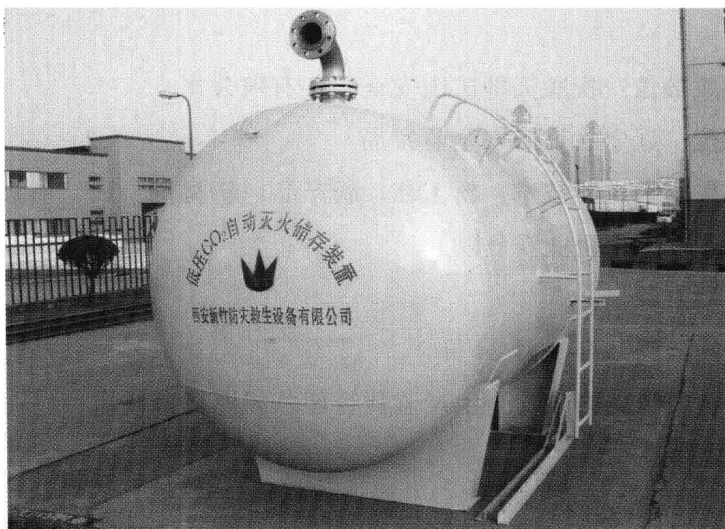
图 2-1 矿用低压储存二氧化碳灭火系统
