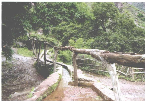
古老的引水木渡槽
