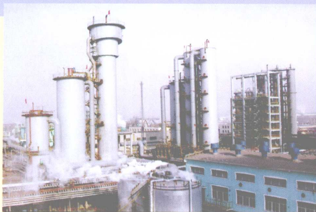
本钢焦化厂二次回收工程
