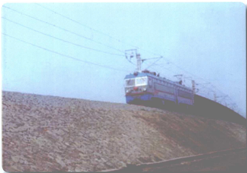
盐渍土地段修建的重载铁路路堤
