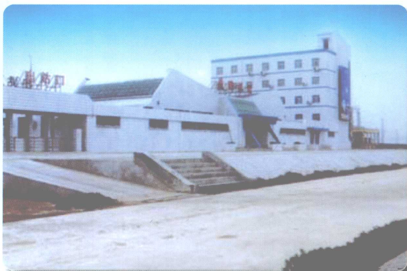
软土地基上修建的黄骅港站站房
