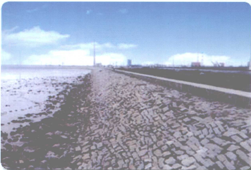
滨海路堤左侧边坡采用栽砌块石护坡与浆砌片石防浪墙防护
