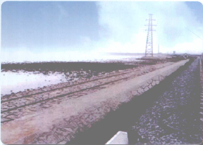
滨海路堤左侧的浆砌片石防浪墙
