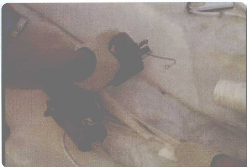
两幅土工布搭接处采用热压焊接
