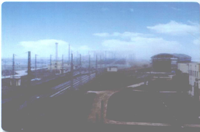
软土地段的黄骅港站站场全貌
