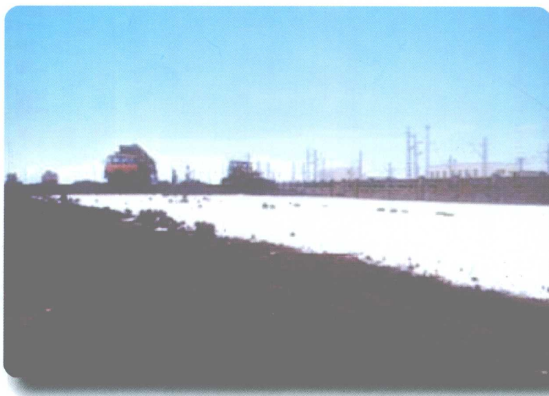
肃黄段用两布一膜土工布处理盐渍土地基
