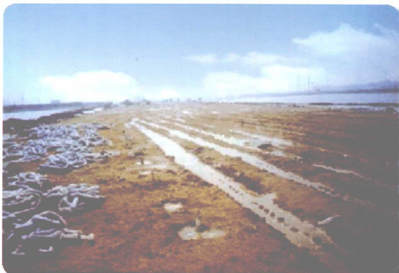
袋装砂井处理软土地基的排水效果
