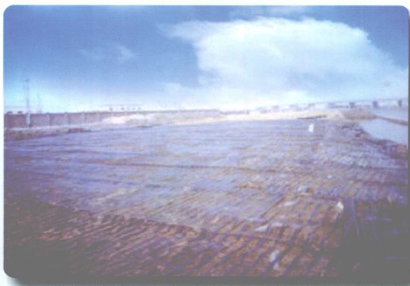
采用砂垫层夹铺土工格栅加固松软地基
