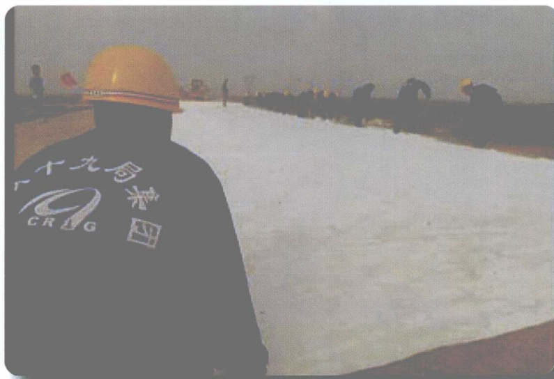
沿路基纵向摊铺开的两布一膜土工布
