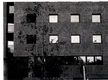
图12 柏林的办公、公寓综合楼立面细部
