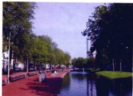
彩图 4-48 混凝土和草坡驳岸 (丁绍刚摄)
