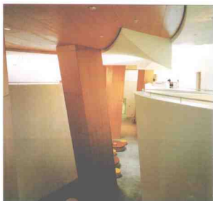
图2-4：对建筑框架结构的遮蔽处理。
