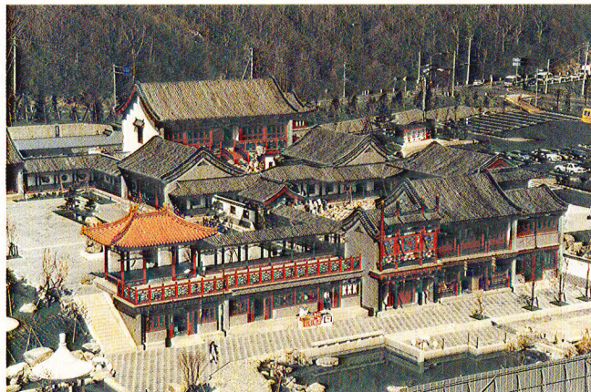
日本天华园前区古建筑群
