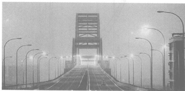
图 1.4 建成后的新光大桥(3)
