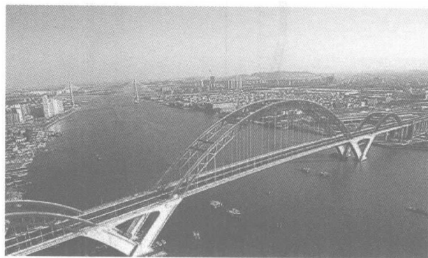
图 1.2 建成后的新光大桥(1)
