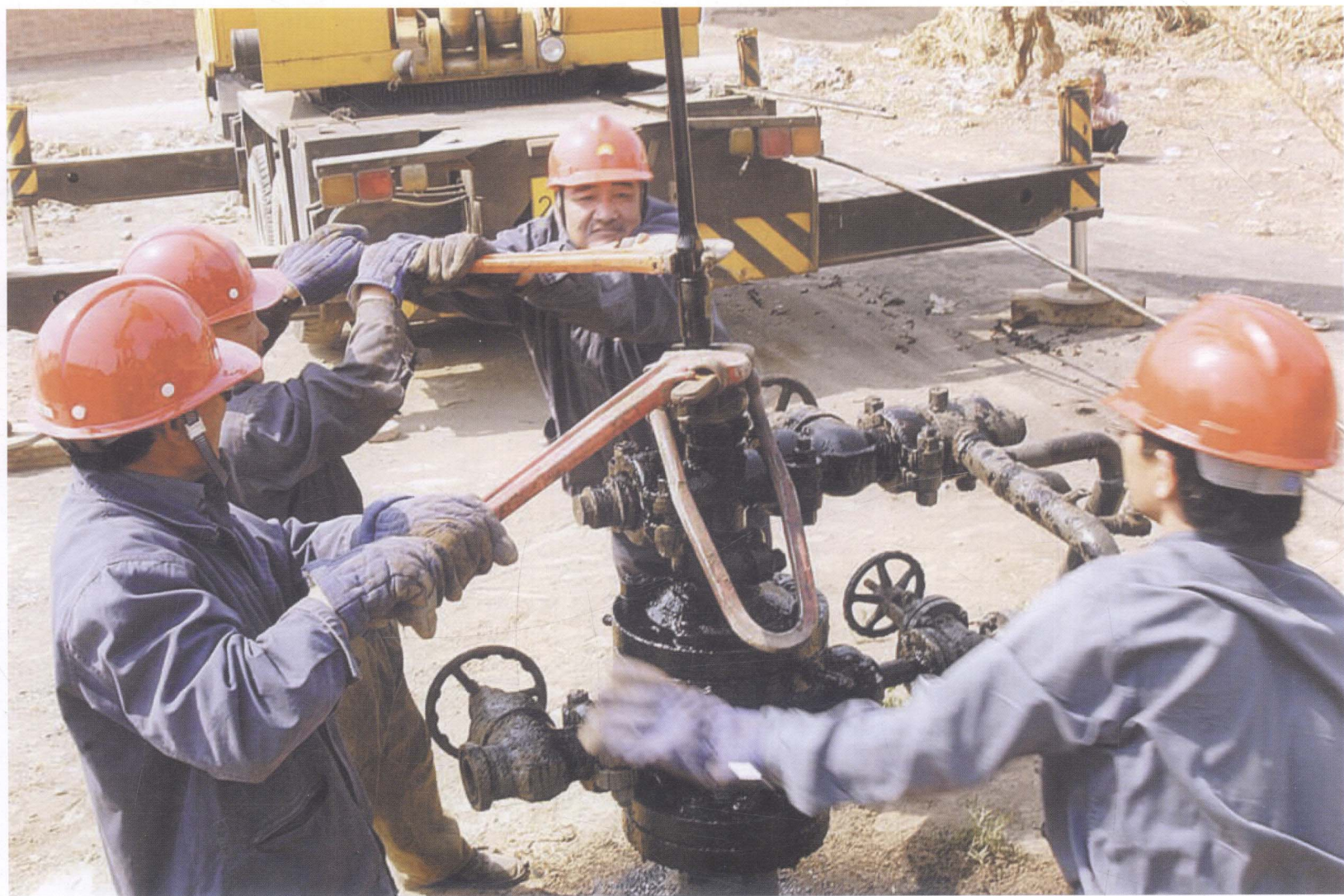
对一些重大维修项目,曹树祥和工友承揽下来,替代外雇施工队伍,节约维修成本。
