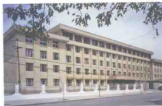
宁夏建筑设计院办公楼
