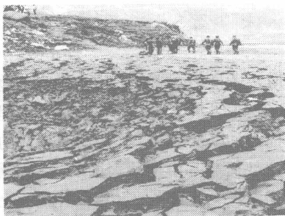
图 1.1 5.12 汶川大地震紫坪铺水库沙土地基被震陷
