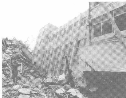
图 1.2 5.12 汶川大地震北川某办公楼整体倾倒
