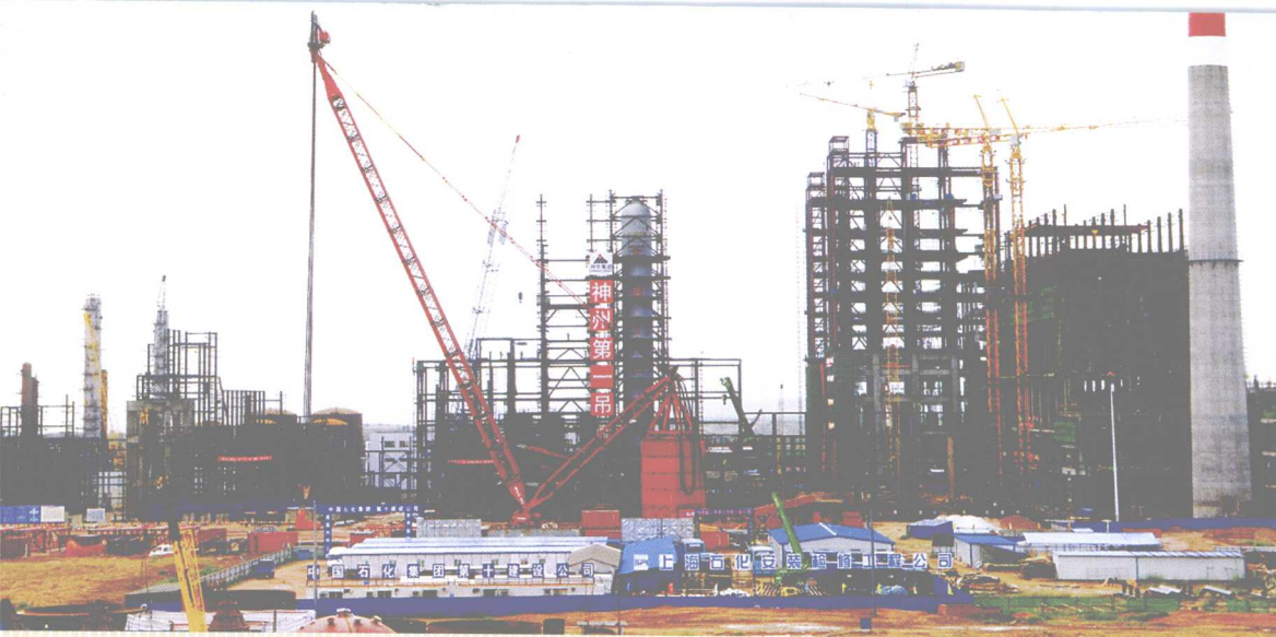
◎ 世界第一条煤直接液化生产线，国内第一条煤间接液化生产线在鄂尔多斯市建设。
