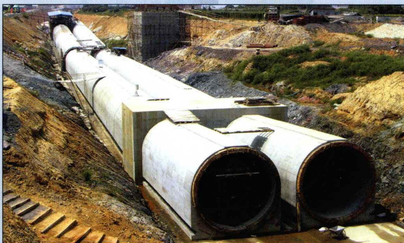
凤凰岗至窑坑3.4km地下圆涵外景
