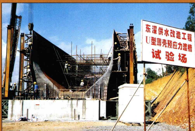
U型薄壳渡槽试验段
