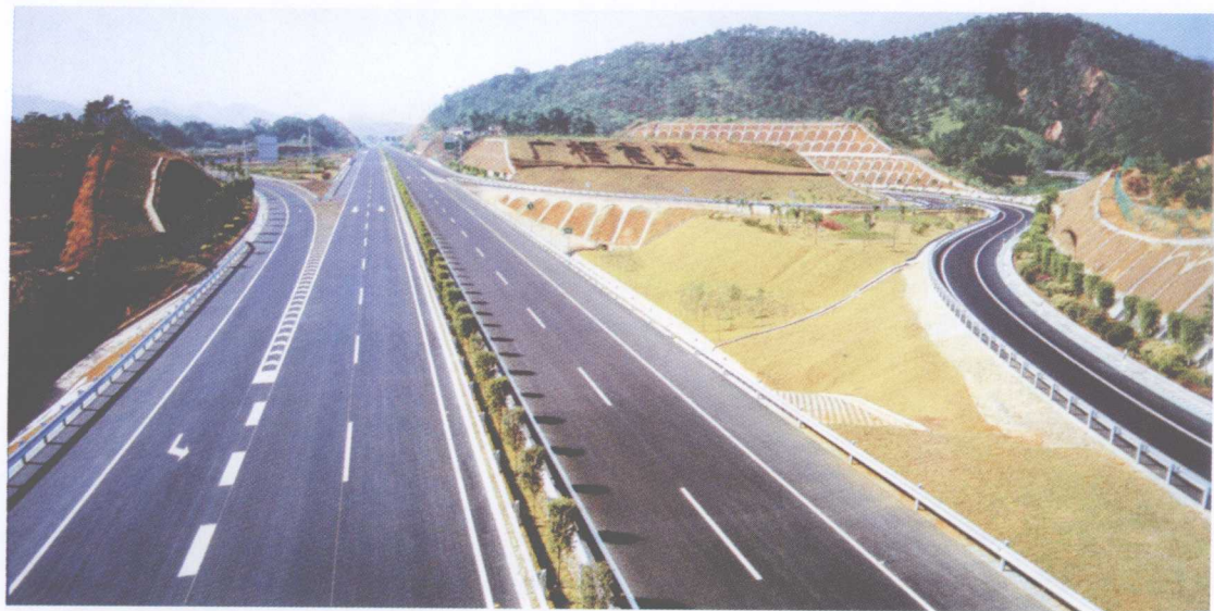
广梧高速公路
