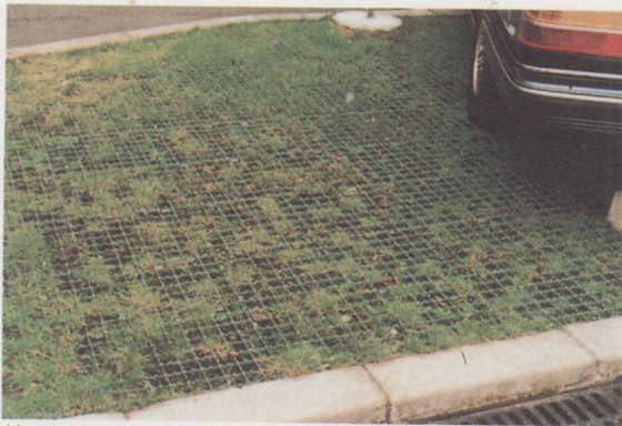
使用草坪保護材面透水性草坪鋪裝
