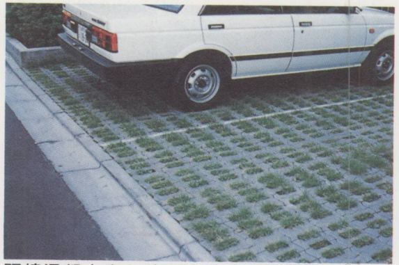
預鑄混凝土空心磚之透水性草坪鋪裝
