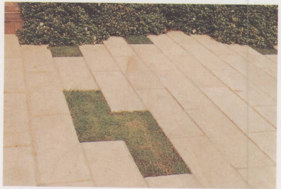
停車場混凝土平版鋪裝
