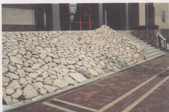
斜面天然石擋土牆
