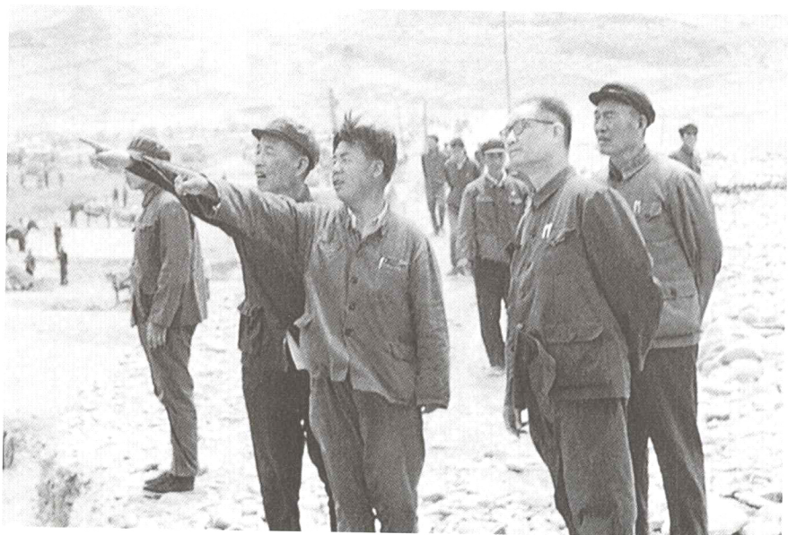
1978年5月，宋平在民乐县瓦房城水库坝上，听取县委书记韩正卿介绍工程进展情况。(马骊骥摄)
