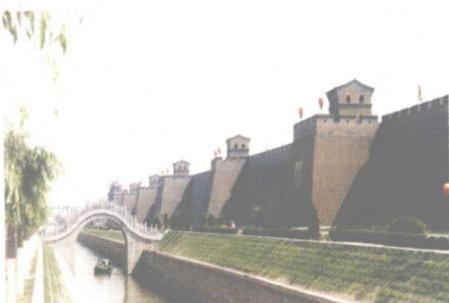
隆庆二年（1569年）维修中拓宽至深宽各三丈（10米），并更新木吊桥。清道光时又再次在护城河三壁包砌砖石，浚通河道，引水入壕，并筑石桥设水闸。此后直至清光绪时仍然使用护城河、吊桥等。这样的城防加上城头上戎装整齐，弓弩齐备的守护兵勇，一旦有警，则戒备森严。小股的“流寇和顽匪”是很难逾越的。
