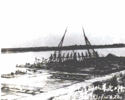
澧市集材场工人文德初于一九五八年发明的沉水压排机曾在全国推广
