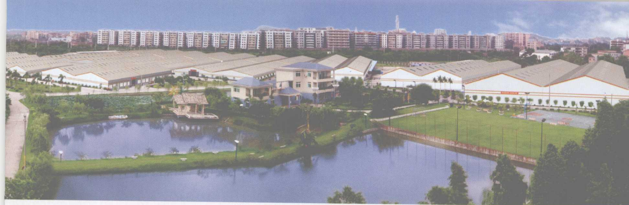
20万平方米欧派花园式工厂 —— 亚洲最大的橱柜生产中心
