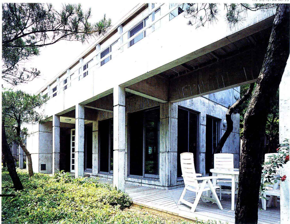
南侧凉台部分
