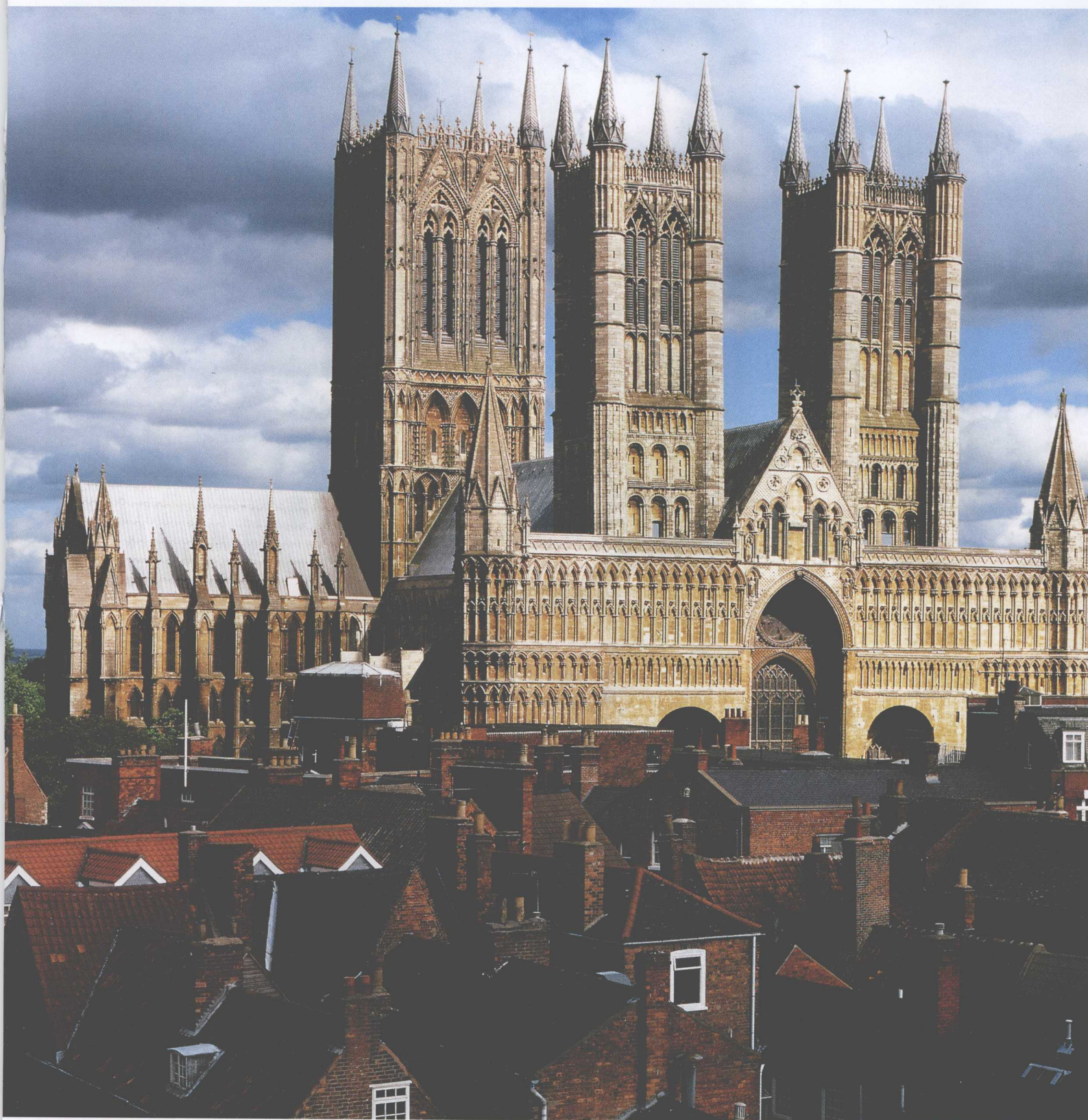
图 5-6 林肯大教堂。西北侧全景
