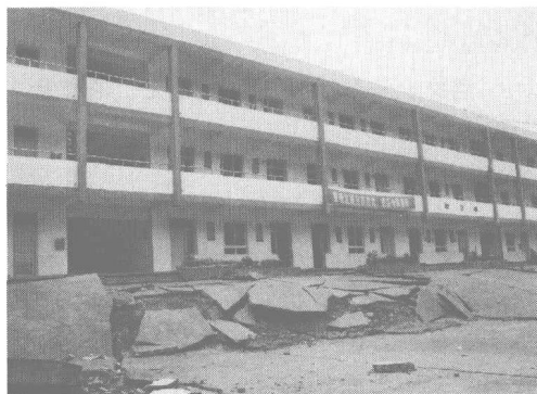
照片 1.2.4 断层附近教学楼完整无损
