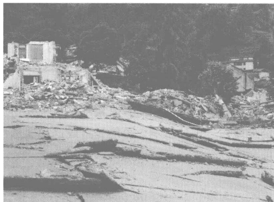
照片 1.2.2 断层附近房屋的破坏
