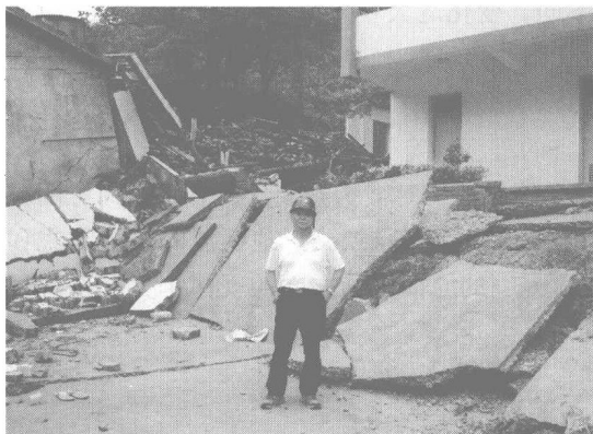
照片 1.2.1 地震后沿断层形成的高差
