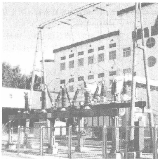
图 1-6 安装在现场的 GW5 户外隔离开关
