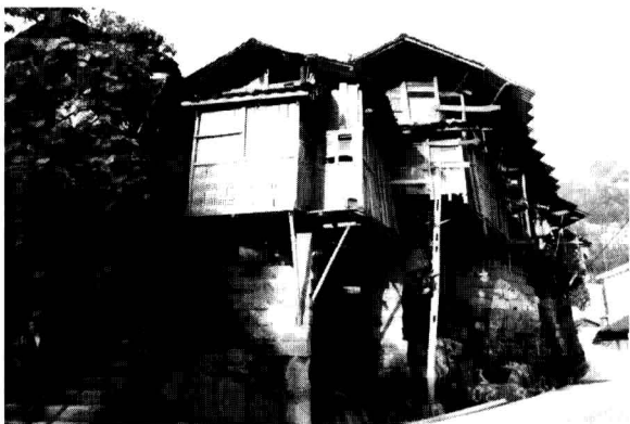
“悬吊吊”的阁楼
