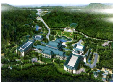
酒店建筑 西区宾馆一期工程
