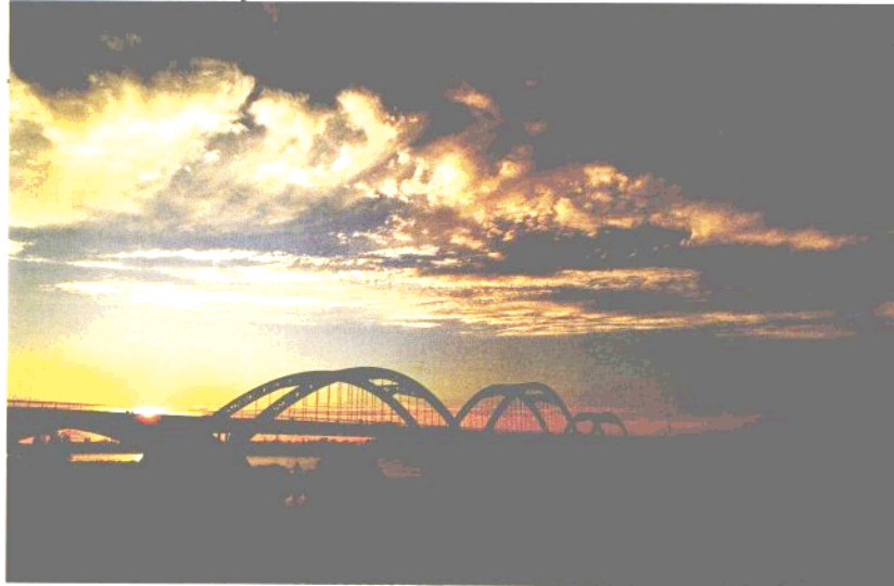
● 横跨浑河南北的长青桥
