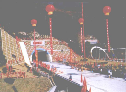
广东梅汕高速公路莲花山隧道
