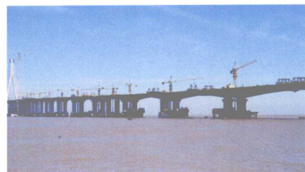
■ 舟山金塘大桥
