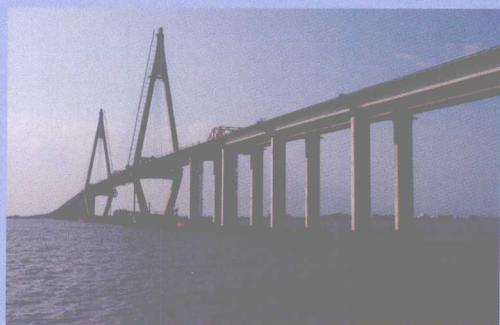
杭州湾跨海大桥
