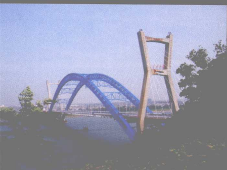
湖南湘潭莲城大桥
