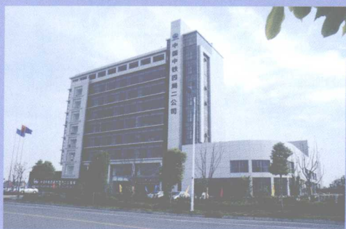
中铁四局二公司苏州办公楼
