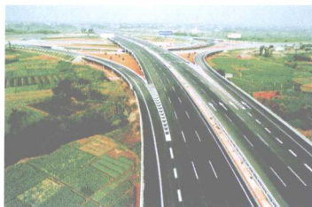
成都绕城高速公路（中国建筑工程“鲁班奖”）
