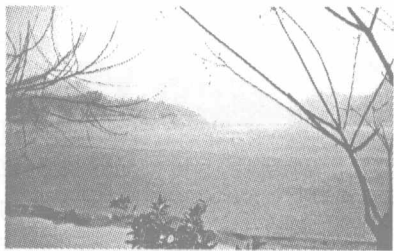
柘溪水库一角
