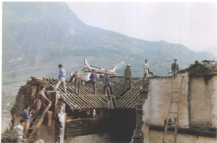
大江截流前文物部门抢救 I 线水位下的古代民居，这是文物部门对秭归县新滩传统民居群中的郑万琅老屋进行搬迁保护的拆迁现场。
