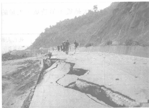
图 1-5 中国四川省汶川地震时产生的地裂缝
