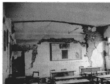
图 1.16 拉结良好的 预制楼板未塌落 (6/7)
