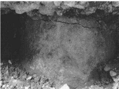
图 1.31 设备基础灌注桩剪断 (7/8~9)
