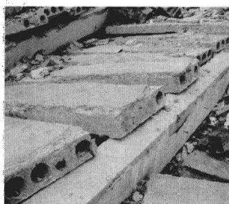
图 1.15 完全没有 拉结的预制板 (7/9)
