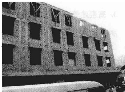
图 1.11 砌体结构住宅楼完好 (7/9)
