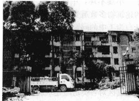
图 1.2 附近的砌体结构住宅楼裂而不倒 (7/11)
