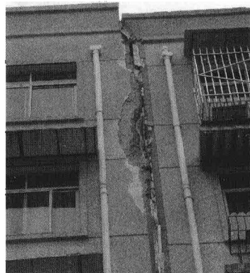
图 1.34 高层建筑防震缝碰撞（7/8）
