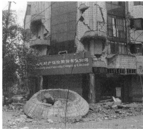
图 1.24 绵竹中行屋角破坏 (7/8 照片由裴友法提供)
